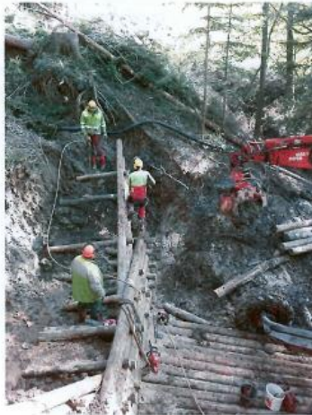
Abbildung 2: Beispiel einer Holzsperrre aus der Steiermark AUT, eingesteckte Flügel erhöhen die seitliche Stabilität (Weitbacher, WLW)
